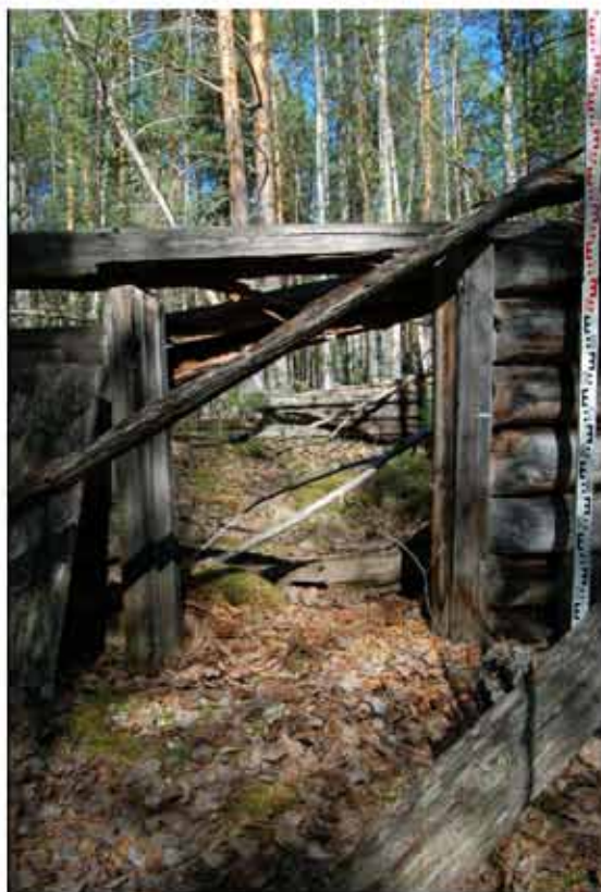
Рис. 11. Юрты Когончиных зимние. Зимний жилой дом № 1. Фрагмент главного фасада. Конструкция дверного проема. Фото М. Н. Пальяновой. 2006 г.
