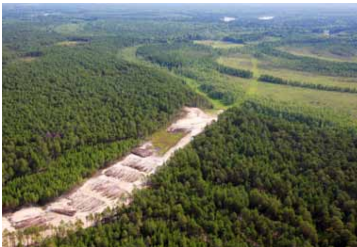
Рис. 3. Сургутский район. Правый коренной берег реки Большой Юган. Участок строящегося коридора коммуникаций к кустовой площадке К-13 Угутского месторождения нефти ООО «РН-Юганскнефтегаз» в районе нахождения городища Нехсап 1. Общий вид с ЮЗ. Июнь 2009 г.
