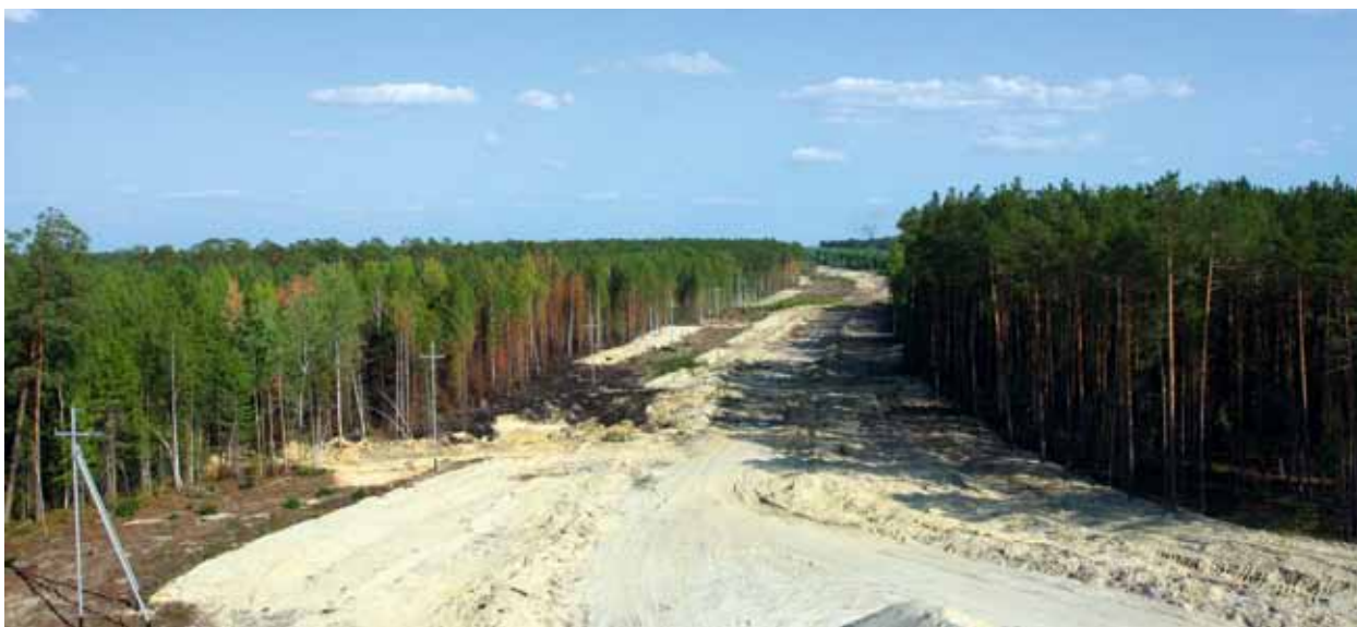
Рис. 9. Правый берег реки Большой Юган. Территория Угутского месторождения нефти ООО «РН-Юганскнефтегаз». Корridor коммуникаций
