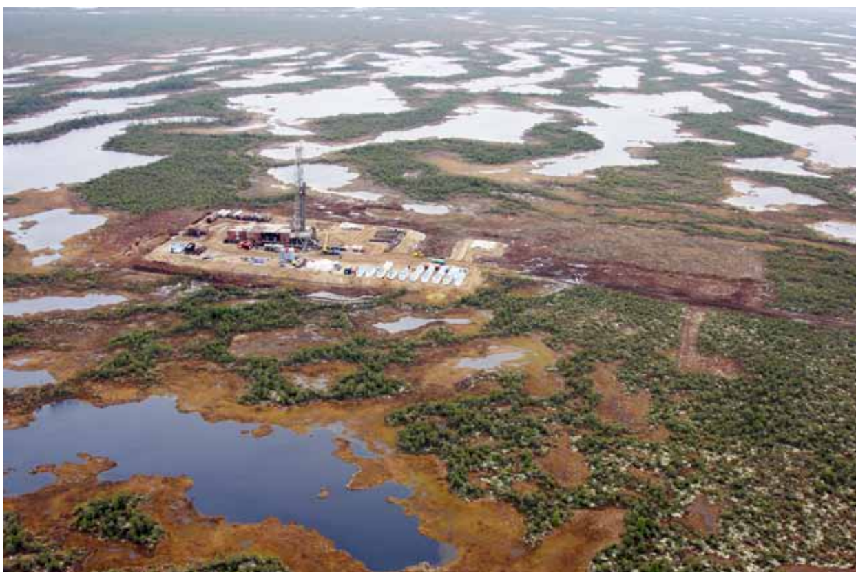
Рис. 4. Сургутский район, верховья реки Большой Салым. Разведочное бурение Северо-Чупальского лицензионного участка ООО «РН-Юганскнефтегаз»
