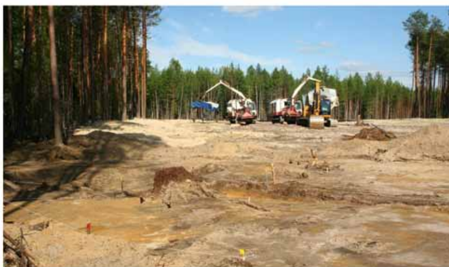
Рис. 2. Строительная техника на разрушенной вырубкой части селища Сартым-урий 16. На переднем плане – раскоп. Фото Ю. П. Чемякина. 2011 г.
