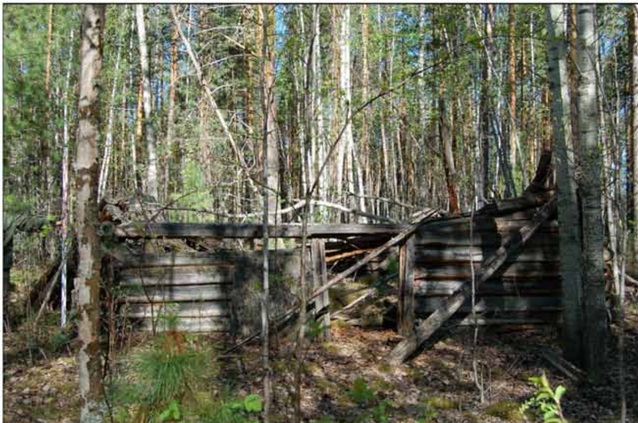
Рис. 8. Юрты Когончиных зимние. Зимний жилой дом № 1. Главный фасад в осях 1–2. Фото М. Н. Пальяновой. 2006 г.
