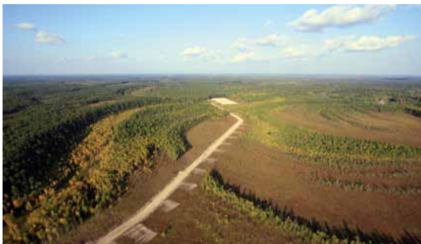
Рис. 4. Сургутский район. Правый коренной берег реки Большой Юган. Участок строящегося коридора коммуникаций к кустовой площадке К-13 Угутского месторождения нефти ООО «РН-Юганскнефтегаз» в районе нахождения городища Нехсап 1. Общий вид с ЮЗ. Июнь 2009 г.
