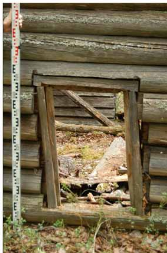
Рис. 26. Юрты Когончиных зимние. Зимний жилой дом № 3. Фрагмент фасада. Конструкция оконного проема. Фото М. Н. Пальяновой. 2006 г.
