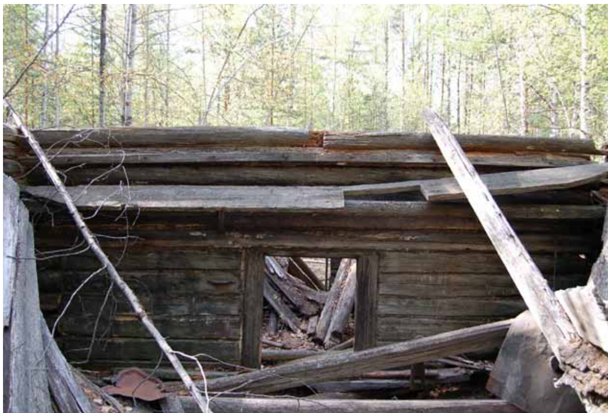
Рис. 19. Юрты Когончиных зимние. Зимний жилой дом № 2. Фрагмент интерьера. Конструкция дверного проема и входа в дом. Нижняя доска фронтона с фрагментом чердачного окна. Фото М. Н. Пальяновой. 2006 г.
