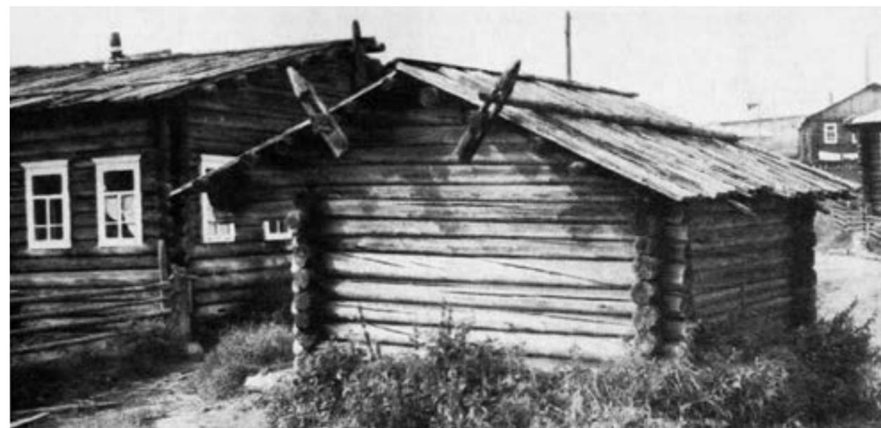
**Рис. 12.** Республика Коми, Усть-Куломский р-н, с. Усть-Нем. Общий вид амбара с гнетами на кровле, укрепленными обоями – чибями
