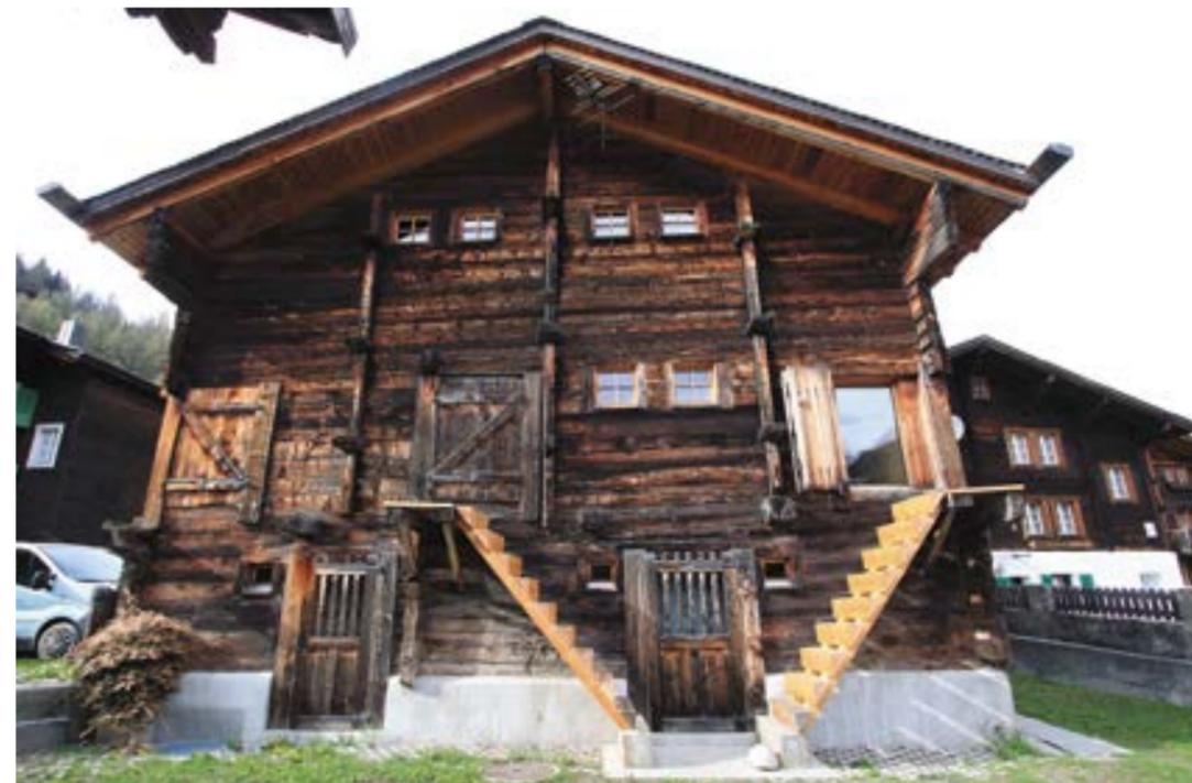
**Рис. 17.** Швейцария, кантон Валлис (Валле), Мюнстер. Главный фасад жилого дома с применением обойм. Фото О. В. Кардаша, 2010 г.
