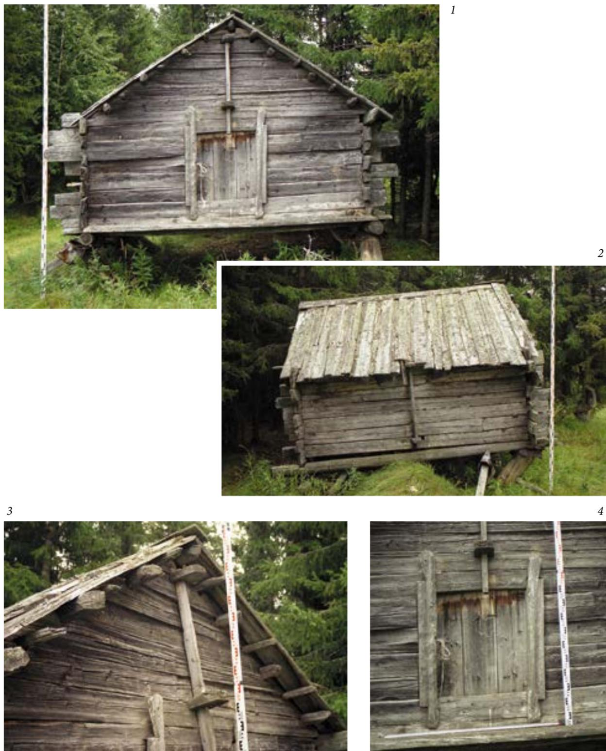
**Рис. 19.** ЯНАО, Шурышкарский район, п. Питляр. Общий вид амбара: 1 – главный лицевой фасад, 2 – левый боковой фасад, 3 – главный лицевой фасад, детали — крепление щепца, 4 – главный лицевой фасад, детали – наружная конструкция дверного проема. Фото М. Н. Пальяновой, 2005 г.
