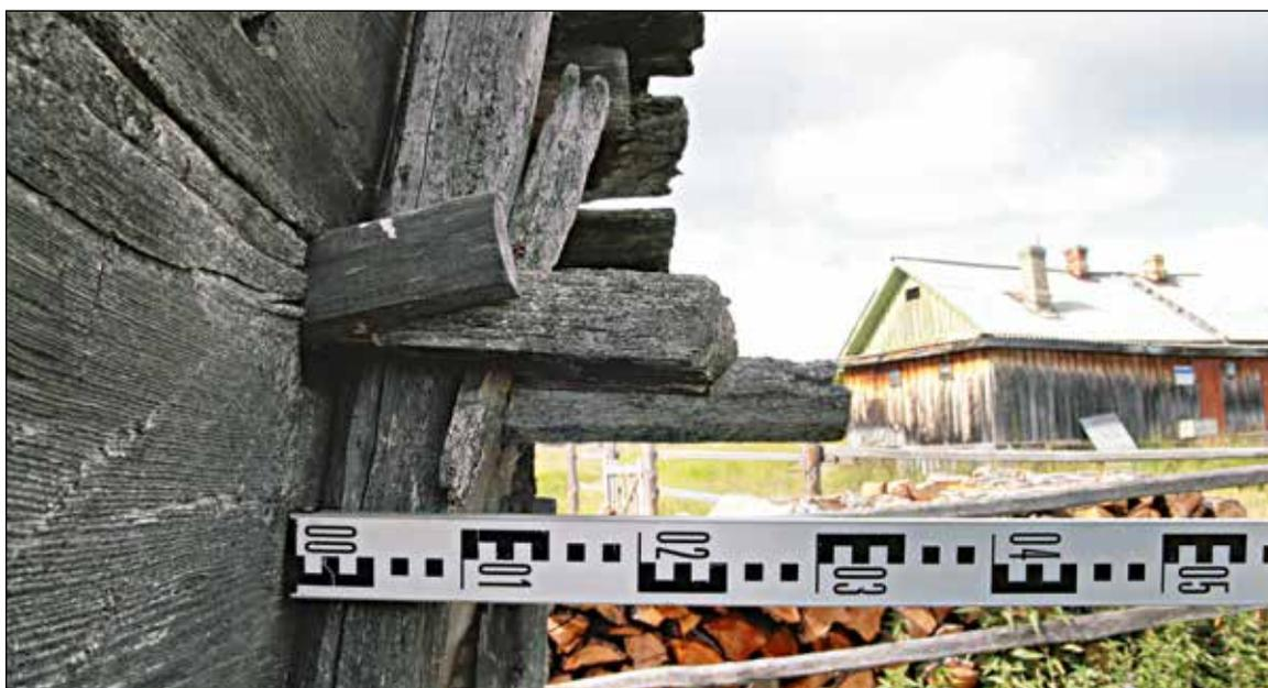
**Рис. 56.** ЯНАО. Шурышкарский район, д. Хашгорт. Постройка 1. Летний «священный» дом А. М. Тырлина. Фрагмент северо-восточного. Узел крепления стойки каркаса деревянным вкладышем к стеновому ограждению, дополнительно укрепленным клиньями. Вид с востока
