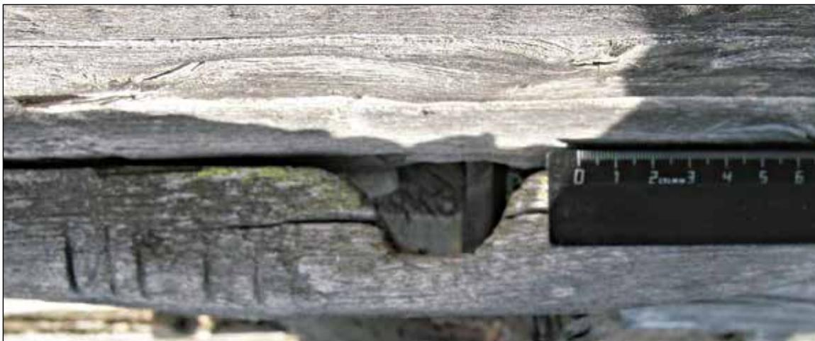
**Рис. 104.** ЯНАО. Шурышкарский район, д. Хашгорт. Постройка 3. Летний дом В. Д. Вакуленко. Фрагмент юго-западного фасада. Дверная конструкция. Деталь первоначальной беспетельной конструкции открывания дверей – гнездо для вставки деревянной втулки. Вид сверху
