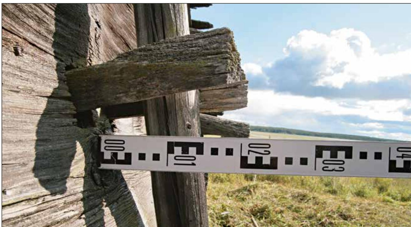
**Рис. 52.** ЯНАО. Шурышкарский район, д. Хашгорт. Постройка 1. Летний «священный» дом А. М. Тырлина. Фрагмент юго-западного фасада. Узел крепления стойки каркаса деревянным вкладышем к стеновому ограждению. Вид с запада
