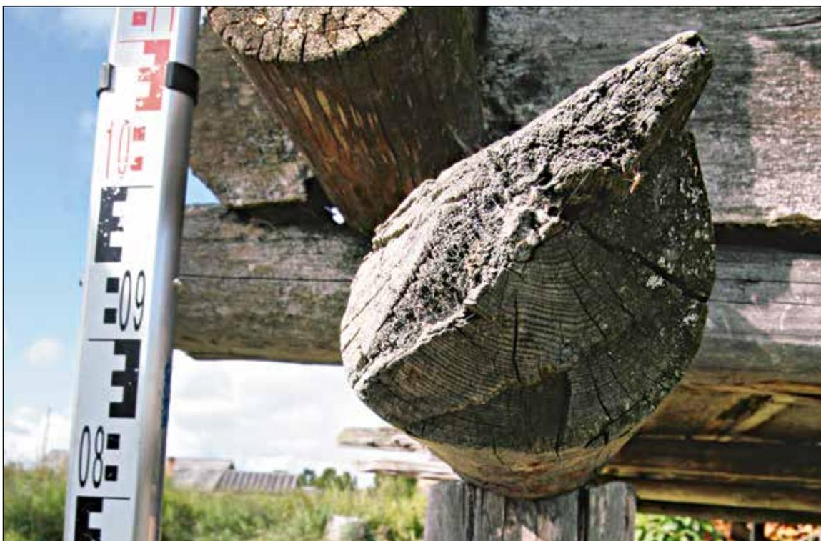
**Рис. 133.** ЯНАО. Шурьшкарский район, д. Хашгорт. Постройка 5. Лабаз. Фрагмент юго-восточного угла. Узел опоры несущей балки на опорный столб. Вид с востока
