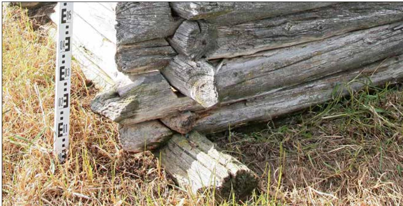
**Рис. 76.** ЯНАО. Шурышкарский район, д. Хашгорт. Постройка 2. Летний дом А. Г. Тырлина. Фрагмент восточного угла. Врубка стеновых плах «в обло». Снизу два окладных венца большим диаметром и с большим выступом относительно остальных венцов. Вид с востока
