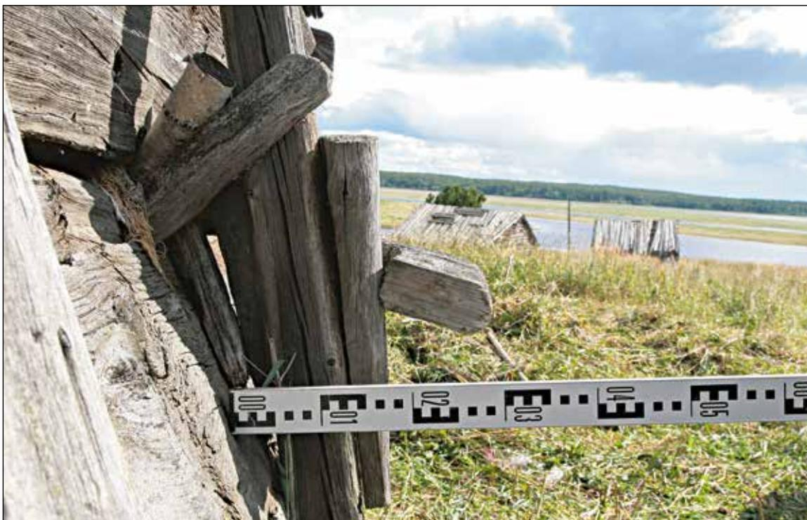
**Рис. 53.** ЯНАО. Шурышкарский район, д. Хашгорт. Постройка 1. Летний «священный» дом А. М. Тырлина. Фрагмент юго-западного фасада. Узел крепления стойки каркаса деревянным вкладышем к стеновому ограждению, дополнительно укрепленный клиньями. Вид с запада
