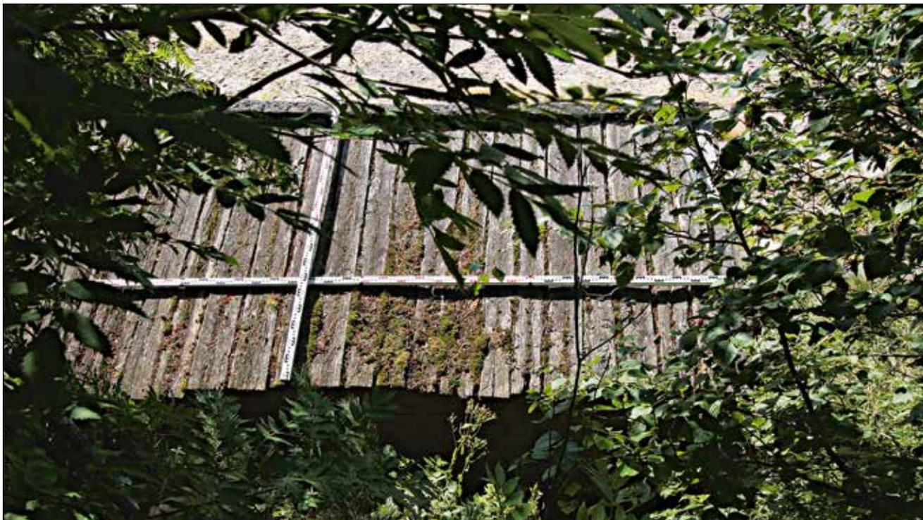
**Рис. 156.** ЯНАО. Шурышкарский район, д. Хашгорт. Постройка 7. Перемещенный летний дом. Фрагмент кровли. Колотые доски теса. Охлупень. Вид с севера
