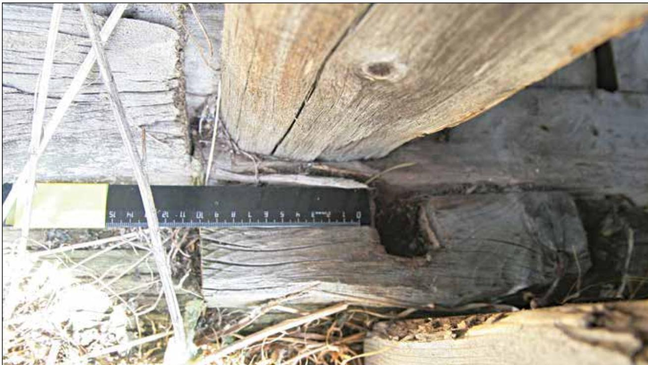
**Рис. 73.** ЯНАО. Шурышкарский район, д. Хашгорт. Постройка 2. Летний дом А. Г. Тырлина. Фрагмент юго-западного фасада. Фрагмент дверной конструкции беспетельного открывания. Нижнее гнездо для деревянной втулки. Вид сверху
