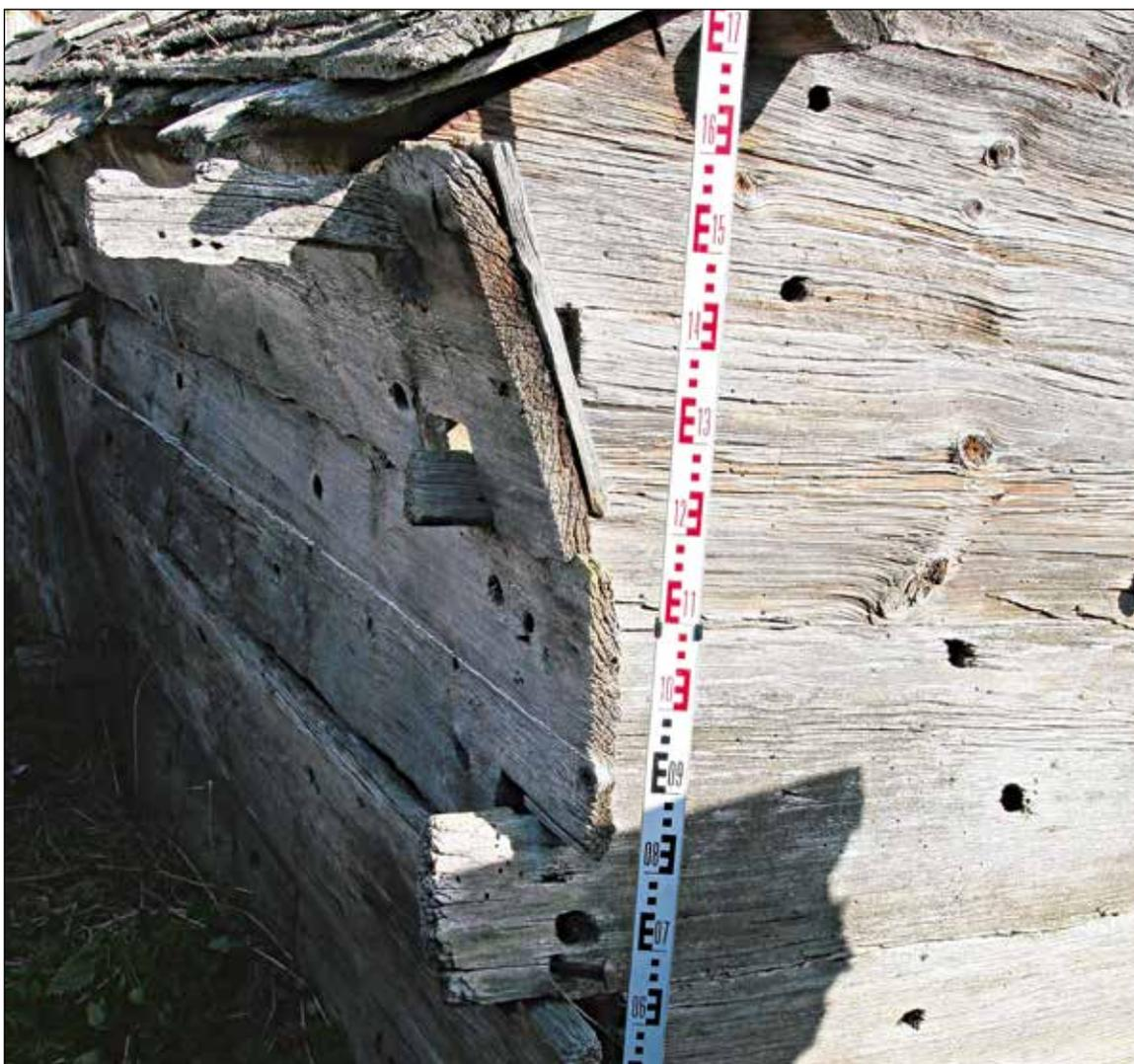
**Рис. 50.** ЯНАО. Шурышкарский район, д. Хашгорт. Постройка 1. Летний «священный» дом А. М. Тырлина. Фрагмент западного угла. Врубка стен «в охряпку». Выступ первой фронтовой доски для крепления гнета. Вид с запада
