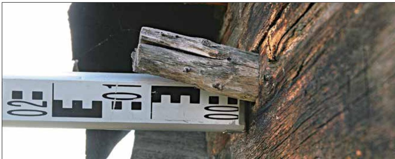
**Рис. 137.** ЯНАО. Шурышкарский район, д. Хашгорт. Постройка 5. Лабаз. Фрагмент восточного фасада. Врубка вешала. Вид с севера
