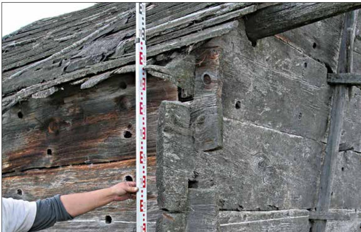
**Рис. 47.** ЯНАО. Шурышкарский район, д. Хашгорт. Постройка 1. Летний «священный» дом А. М. Тырлина. Фрагмент восточного угла. Врубка стен «в охряпку». Выступ первой фронтовой доски для крепления гнета. Вид с востока
