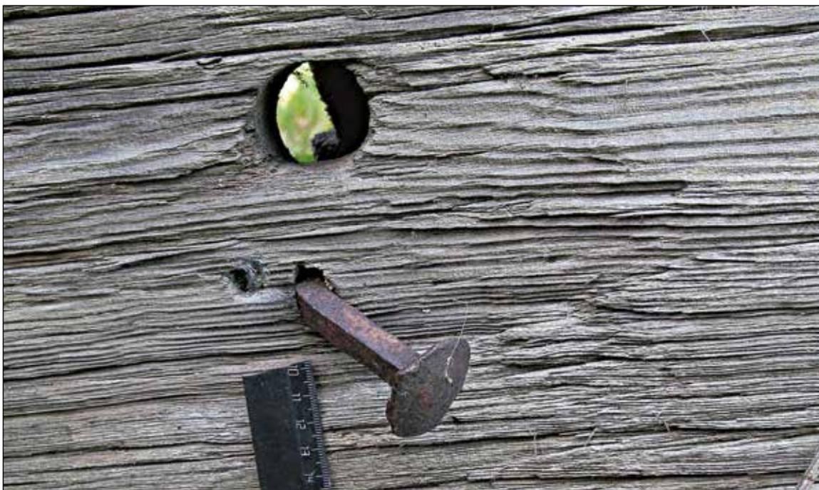
**Рис. 58.** ЯНАО. Шурышкарский район, д. Хашгорт. Постройка 1. Летний «священный» дом А. М. Тырлина. Фрагмент юго-западного фасада. Дощатые стены дополнительно крепились кованными гвоздями. Вид с юго-востока
