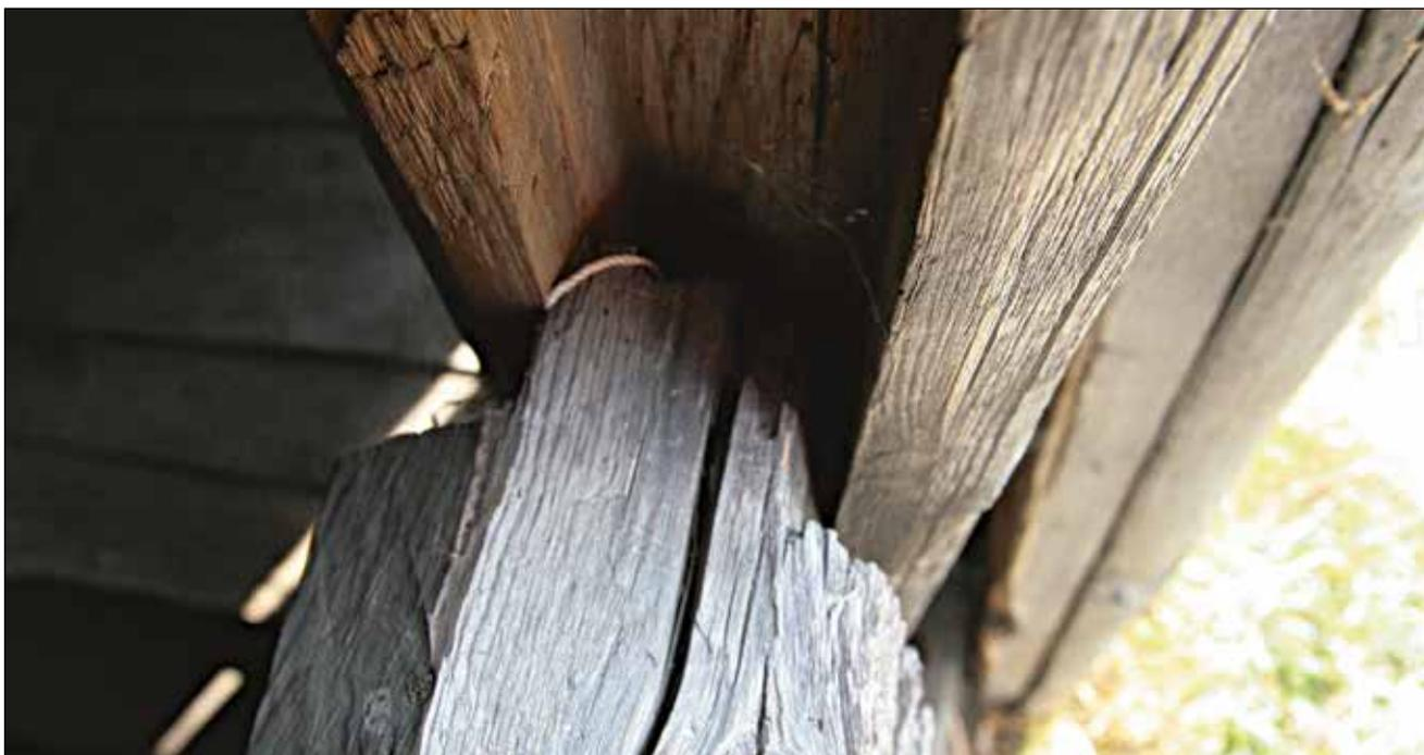
**Рис. 74.** ЯНАО. Шурышкарский район, д. Хашгорт. Постройка 2. Летний дом А. Г. Тырлина. Фрагмент юго-западного фасада. Врубка стеновых плах в дверную коробку. Вид сверху
