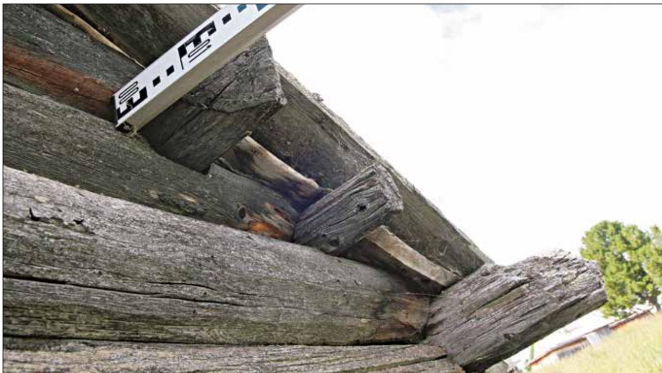
**Рис. 82.** ЯНАО. Шурышкарский район, д. Хашгорт. Постройка 2. Летний дом А. Г. Тырлина. Фрагмент северо-восточного фасада. Узлы врубки слег в плахи фронтона. Край берестяного гидроизоляционного покрытия. Вид с северо-запада
