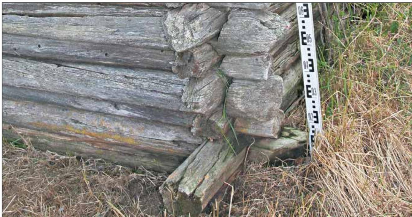
**Рис. 77.** ЯНАО. Шурышкарский район, д. Хашгорт. Постройка 2. Летний дом А. Г. Тырлина. Фрагмент северного угла. Врубка стеновых плах «в обло». Снизу два окладных венца большим диаметром и с большим выступом относительно остальных венцов. Вид с севера
