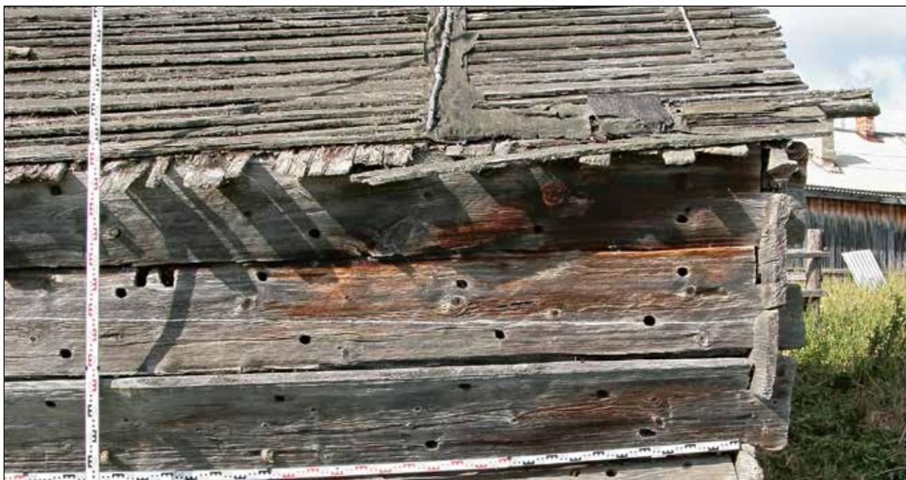
**Рис. 40.** ЯНАО. Шурышкарский район, д. Хашгорт. Постройка 1. Летний «священный» дом А. М. Тырлина. Фрагмент юго-восточного фасада. В центре фасада пазы от утраченных вкладышей для крепления стоек к стеновому ограждению
