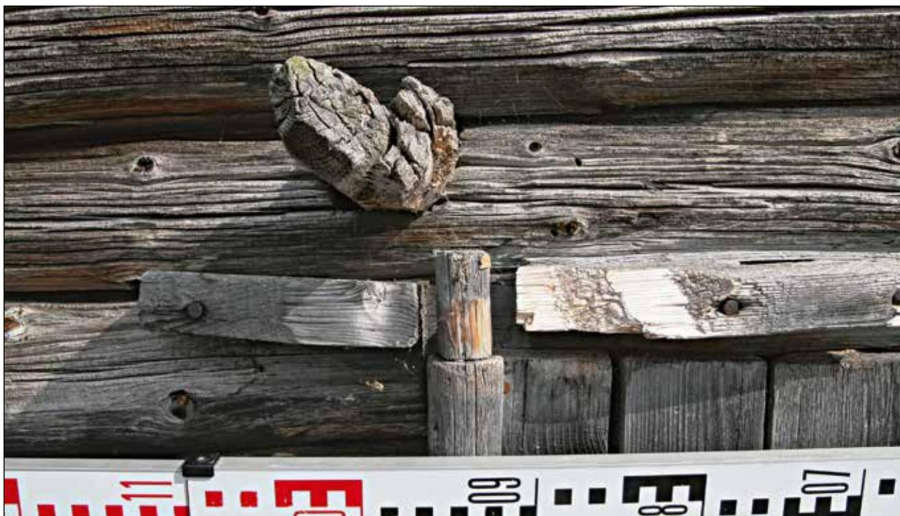
**Рис. 67.** ЯНАО. Шурышкарский район, д. Хашгорт. Постройка 2. Летний дом А. Г. Тырлина. Фрагмент юго-западного фасада. Фрагмент дверной конструкции беспетельного открывания. Деревянная втулка, вставленная в гнездо. Вид с юго-запада
