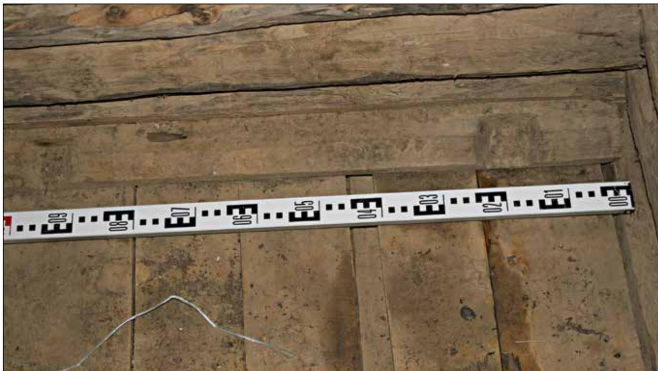
**Рис. 176.** ЯНАО. Шурышкарский район, д. Хашгорт. Постройка 9. Старый амбар. Интерьер. Фрагмент пола. Два вырuba, вероятно, для устройства перегородок. Вид на северную стену
