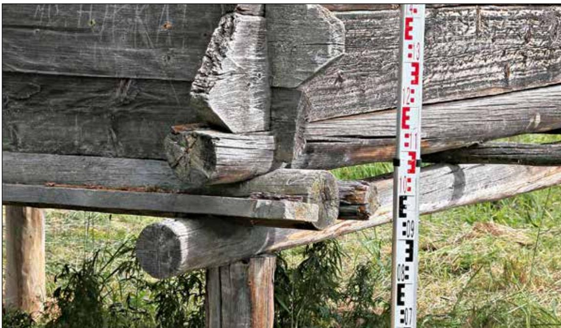
**Рис. 132.** ЯНАО. Шурьшкарский район, д. Хашгорт. Постройка 5. Лабаз. Фрагмент юго-западного угла. Узел опоры постройки на возвышающий ее каркас. Опорный столб и несущая балка. Нижний венец – рубка «в обло». Врубка стен «в охряпку». Вид с юго-запада
