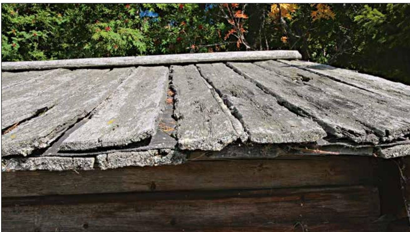
**Рис. 157.** ЯНАО. Шурышкарский район, д. Хашгорт. Постройка 7. Перемещенный летний дом. Фрагмент кровли. Колотые доски теса в два слоя, между ними уложен рубероид. Охлупень. Вид с юга
