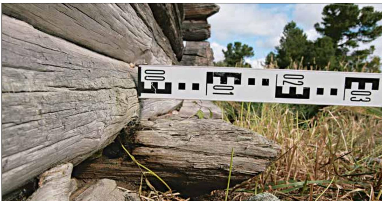
**Рис. 79.** ЯНАО. Шурышкарский район, д. Хашгорт. Постройка 2. Летний дом А. Г. Тырлина. Фрагмент юго-восточного фасада. Узел врубки балки перекрытия, несущей пол, в продольную стену дома. Вид с юга
