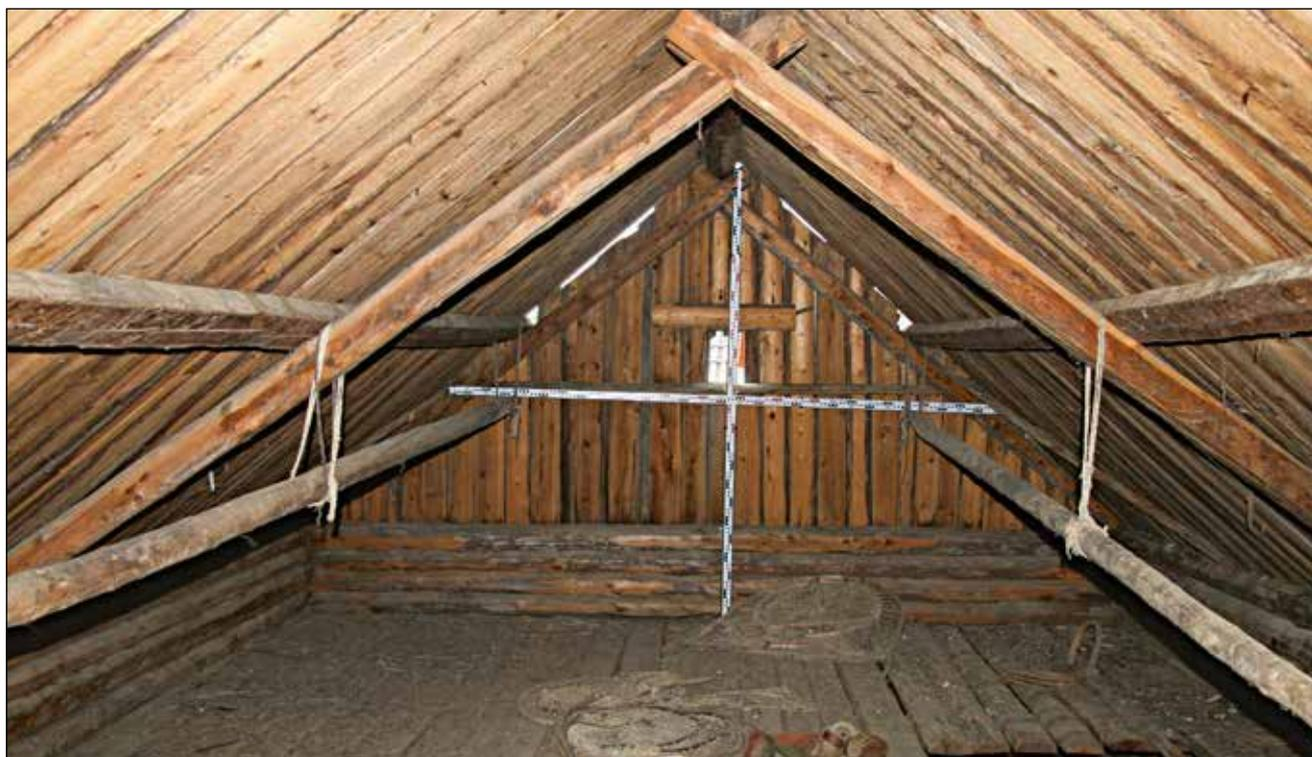
**Рис. 177.** ЯНАО. Шурышкарский район, д. Хашгорт. Постройка 9. Старый амбар. Интерьер. Второй этаж. Устройство крыши. Два подвесных вешала. Окно для проветривания. Вид на западную стену
