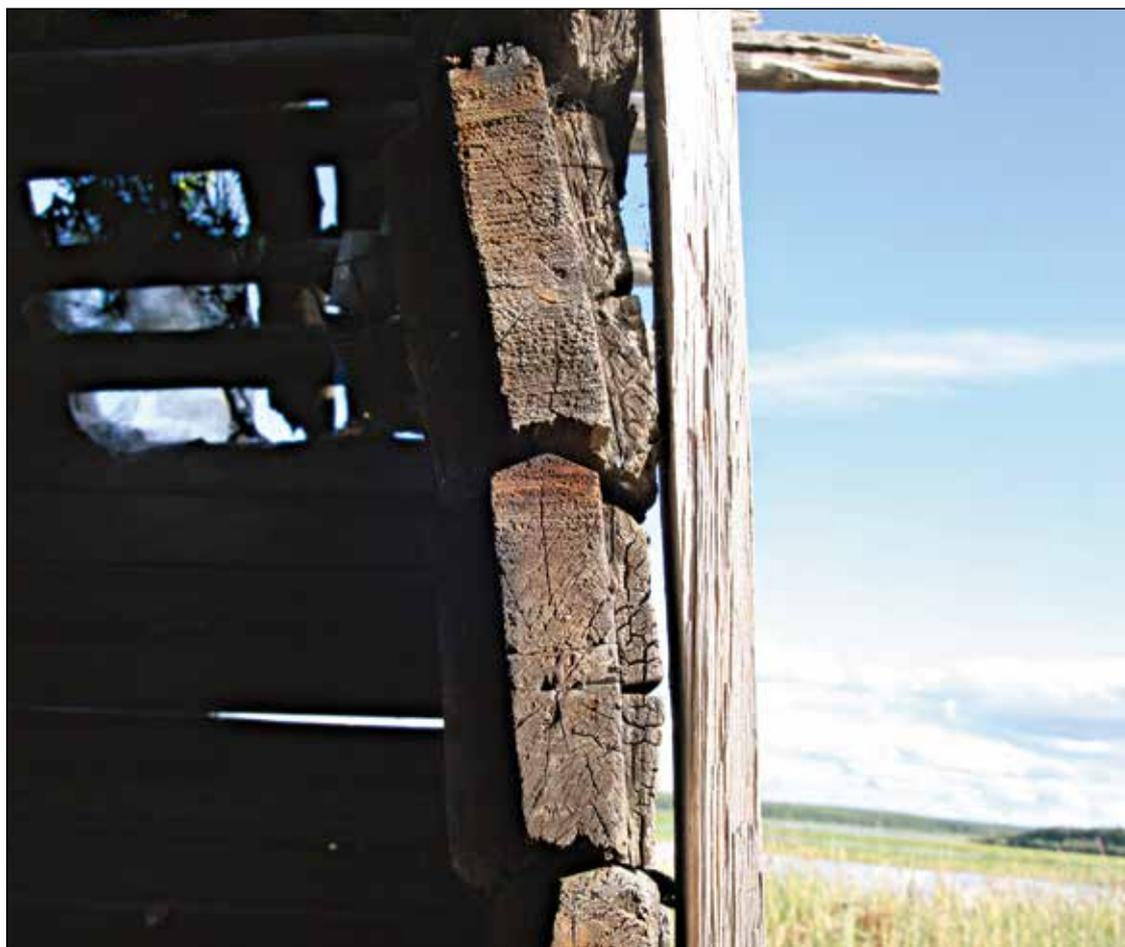
**Рис. 105.** ЯНАО. Шурышкарский район, д. Хашгорт. Постройка 3. Летний дом В. Д. Вакуленко. Фрагмент юго-западного фасада. Дверная конструкция. Способ врубки стеновых плах в дверную коробку. Вид с запада
