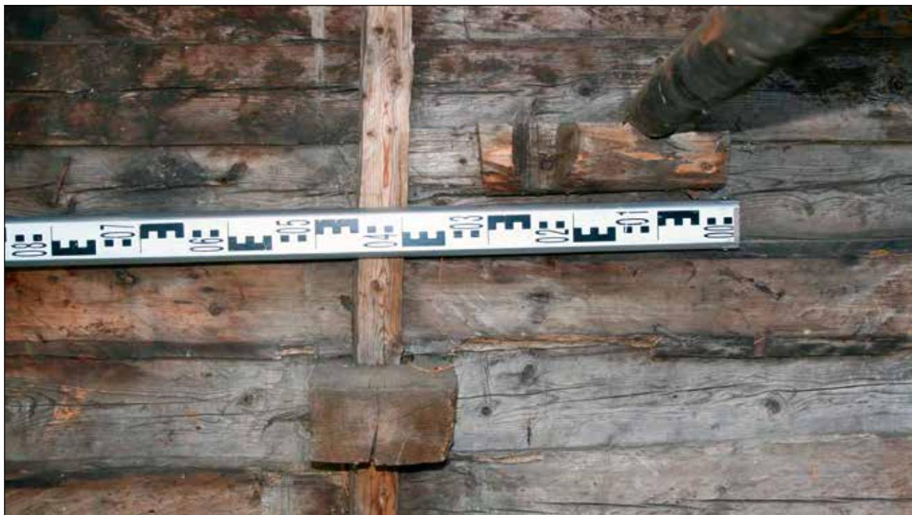
**Рис. 120.** ЯНАО. Шурышкарский район, д. Хашгорт. Постройка 3. Летний дом В. Д. Вакуленко. Интерьер. Узел крепления стойки каркаса к стеновому ограждению деревянной обоймой. Узел крепления вешала к северо-восточной стене, опертая на небольшую плаху. Вид на северо-восточную стену
