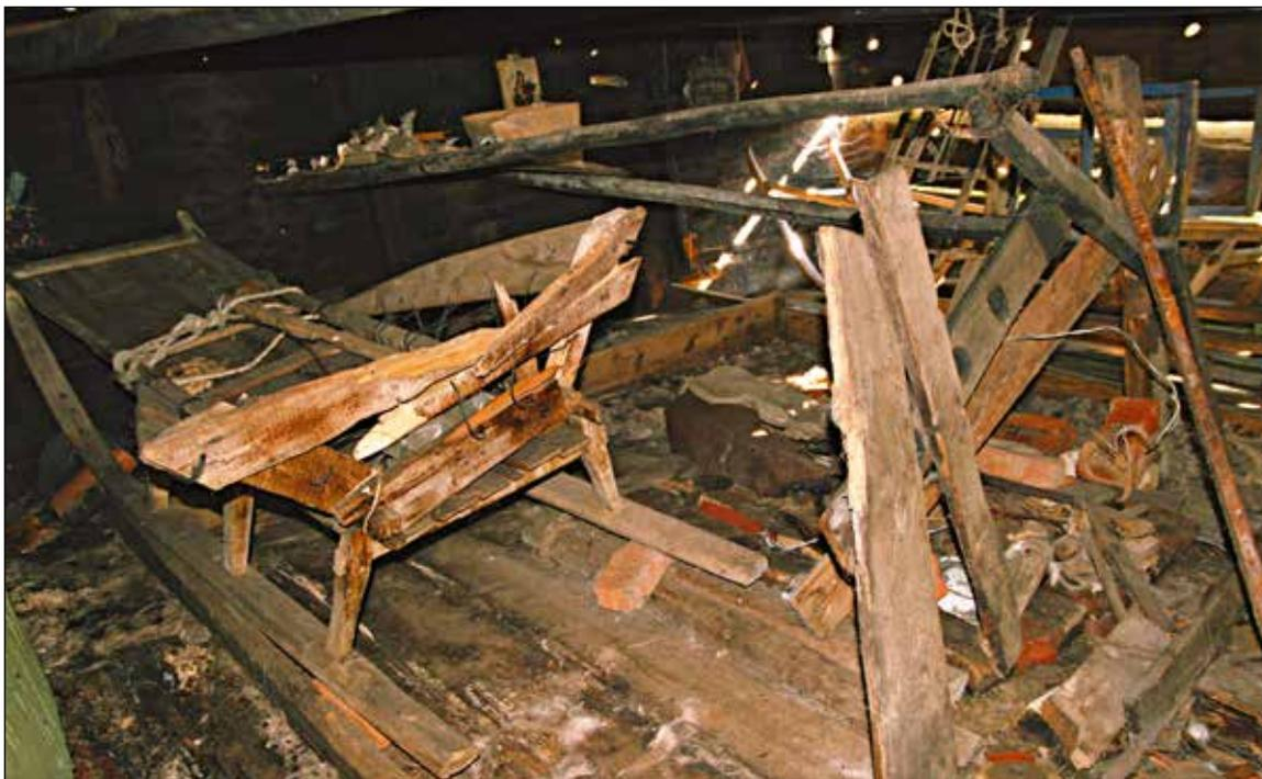
**Рис. 61.** ЯНАО. Шурышкарский район, д. Хашгорт. Постройка 1. Летний «священный» дом А. М. Тырлина. Интерьер. Разрушенный очаг. Видна очажная рама с кирпичной обкладкой. Сохранились стойки очага, поддерживающие вешала. Вид на северо-восточную стену
