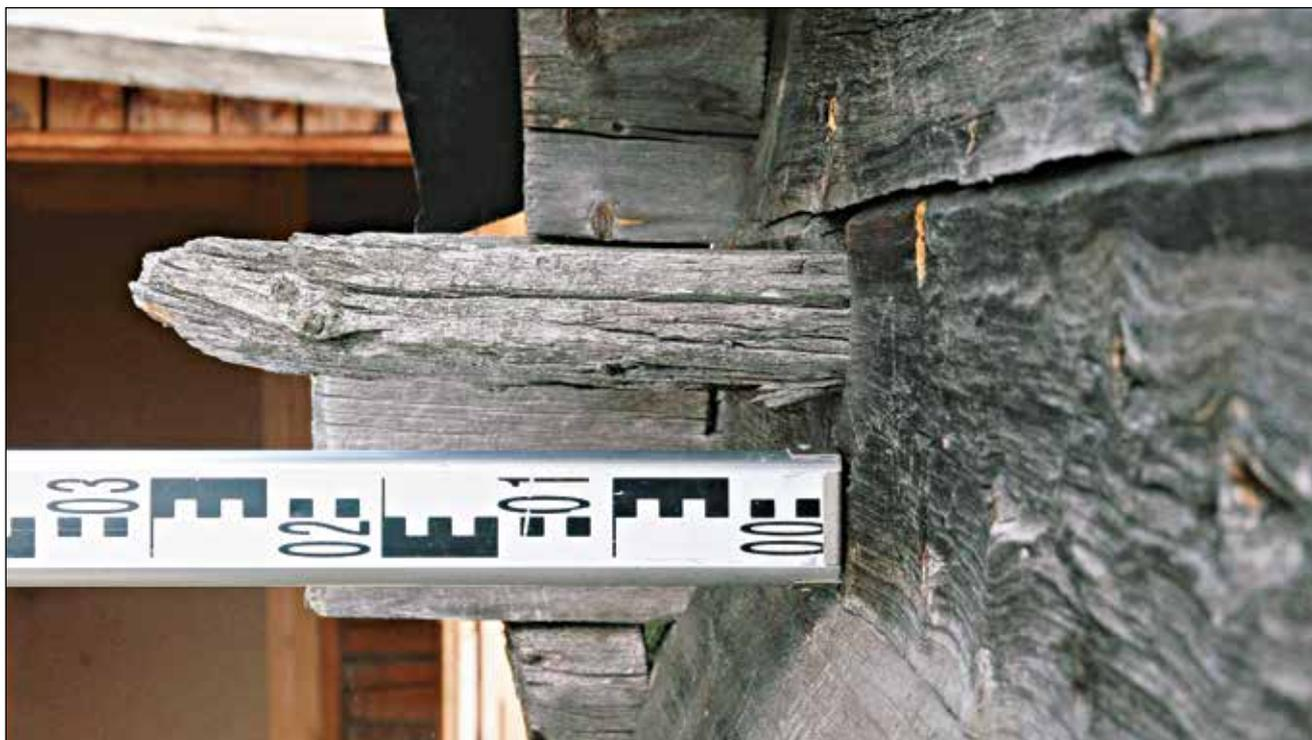
**Рис. 138.** ЯНАО. Шурышкарский район, д. Хашгорт. Постройка 5. Лабаз. Фрагмент западного фасада. Врубка вешала. Вид с юга
