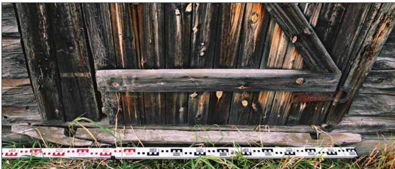
**Рис. 171.** ЯНАО. Шурышкарский район, д. Хашгорт. Постройка 9. Старый амбар. Фрагмент южного фасада. Фрагмент дверной конструкции. Планка с двумя гнездами. Вероятно, для дверных деревянных втулок беспетельного открывания дверей. Вид с юга
