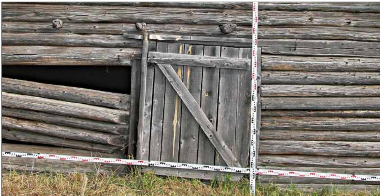
**Рис. 71.** ЯНАО. Шурышкарский район, д. Хашгорт. Постройка 2. Летний дом А. Г. Тырлина. Фрагмент юго-западного фасада. Дверная конструкция. Узлы врубки нижнего ряда вешал.
