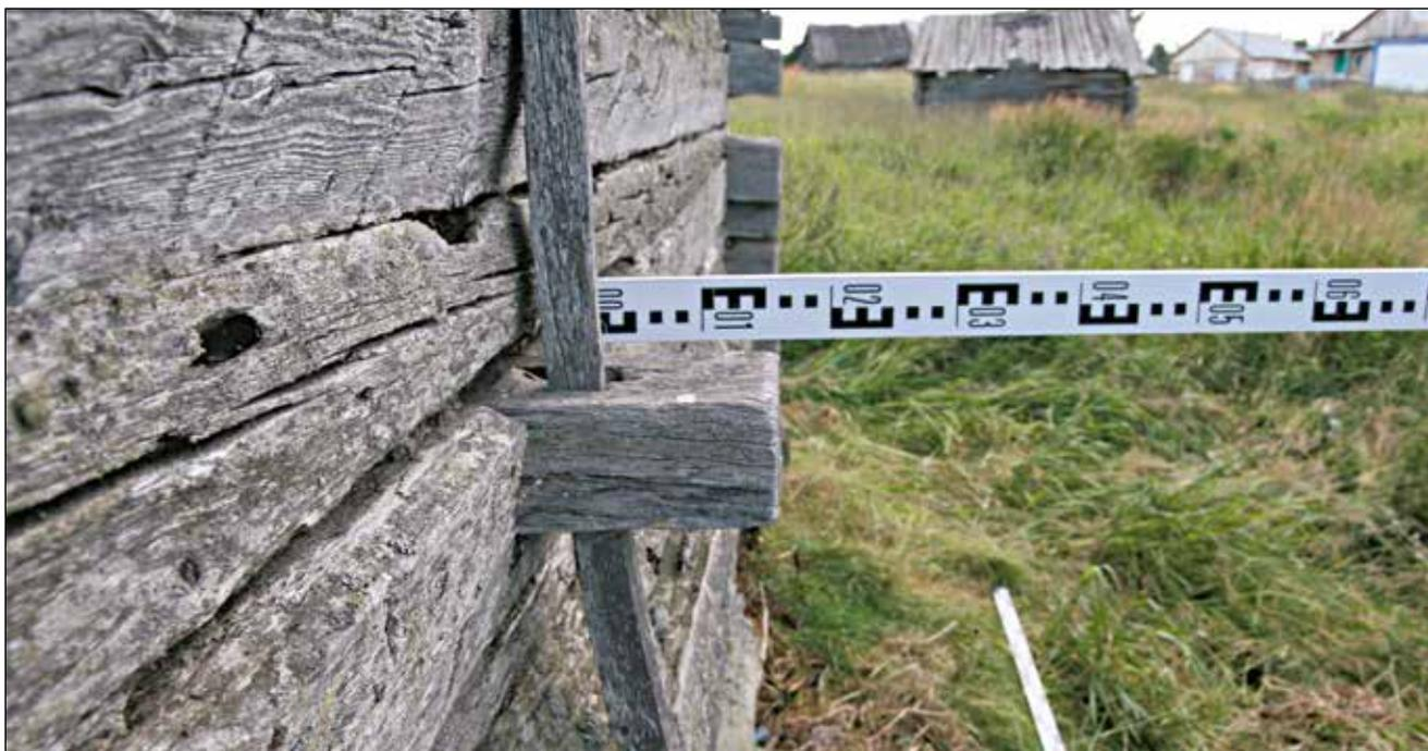
**Рис. 111.** ЯНАО. Шурышкарский район, д. Хашгорт. Постройка 3. Летний дом В. Д. Вакуленко. Фрагмент северо-восточного фасада. Узел крепления стойки каркаса к стеновому ограждению деревянным вкладышем. Вид с востока
