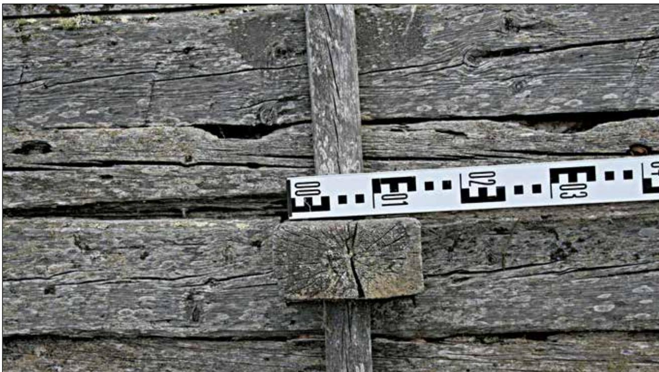
**Рис. 110.** ЯНАО. Шурышкарский район, д. Хашгорт. Постройка 3. Летний дом В. Д. Вакуленко. Фрагмент северо-восточного фасада. Узел крепления стойки каркаса к стеновому ограждению деревянным вкладышем. Вид с северо-востока
