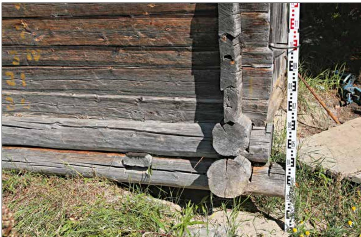
**Рис. 151.** ЯНАО. Шурышкарский район, д. Хашгорт. Постройка 7. Перемещенный летний дом. Фрагмент южного фасада. Два нижних венца бревенчатые, остальные – из бруса. Врубка стен «в обло». В нижний венец врублена балка, несущая доски пола. Вид с юга
