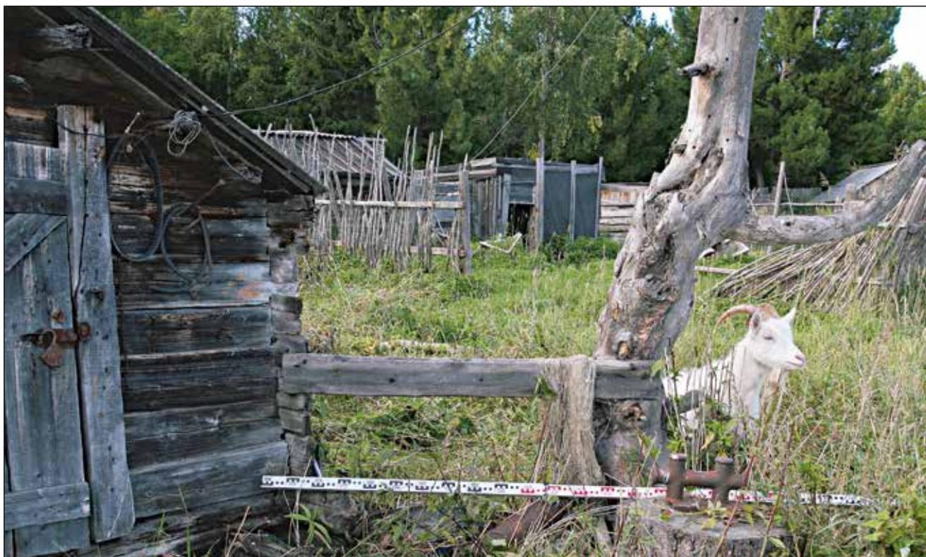
**Рис. 191.** ЯНАО. Шурышкарский район, д. Хашгорт. Постройка 12. Перемещенный лабаз. Северо-восточный угол. К углу постройки и к дереву прибита доска, служащая вешалом. Вид с юго-востока
