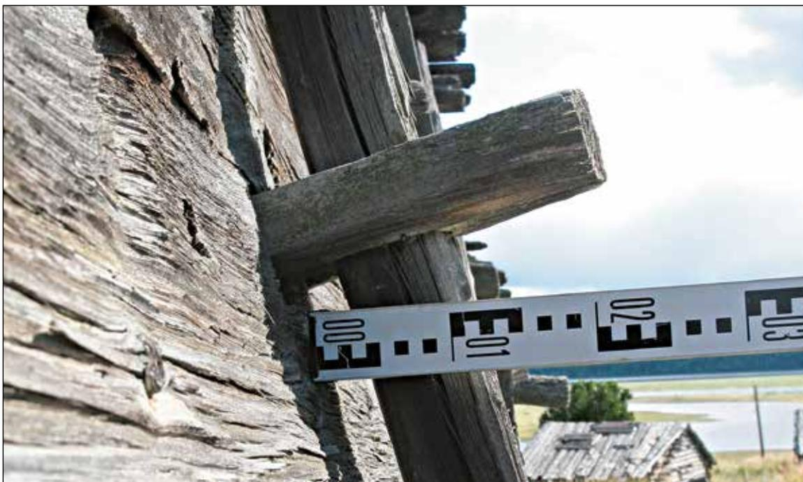
**Рис. 54.** ЯНАО. Шурышкарский район, д. Хашгорт. Постройка 1. Летний «священный» дом А. М. Тырлина. Фрагмент юго-западного фасада. Узел крепления стойки каркаса деревянным вкладышем к стеновому ограждению. Вид с запада
