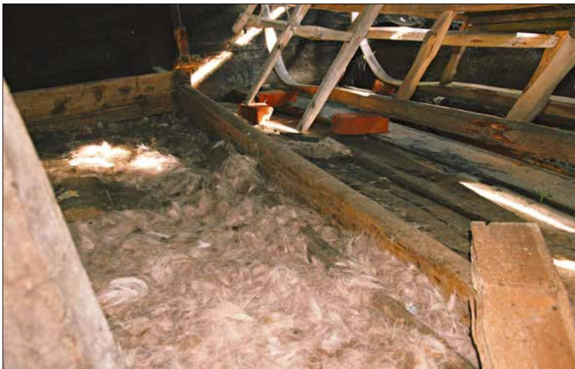
**Рис. 59.** ЯНАО. Шурышкарский район, д. Хашгорт. Постройка 1. Летний «священный» дом А. М. Тырлина. Интерьер дома поделен на функциональные зоны при помощи массивных досок, поставленных на ребро. Они отделяли спальные зоны от центральной зоны с очагом. Сейчас помещение используется как сарай для хранения вещей и сушки заготовок. Вид на северо-восточную стену
