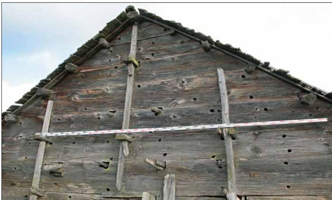
**Рис. 36.** ЯНАО. Шурышкарский район, д. Хашгорт. Постройка 1. Летний «священный» дом А. М. Тырлина. Фрагмент юго-западного фасада. Узлы крепления стоек каркаса деревянными вкладышами к стеновому ограждению. Узлы врубки вешал
