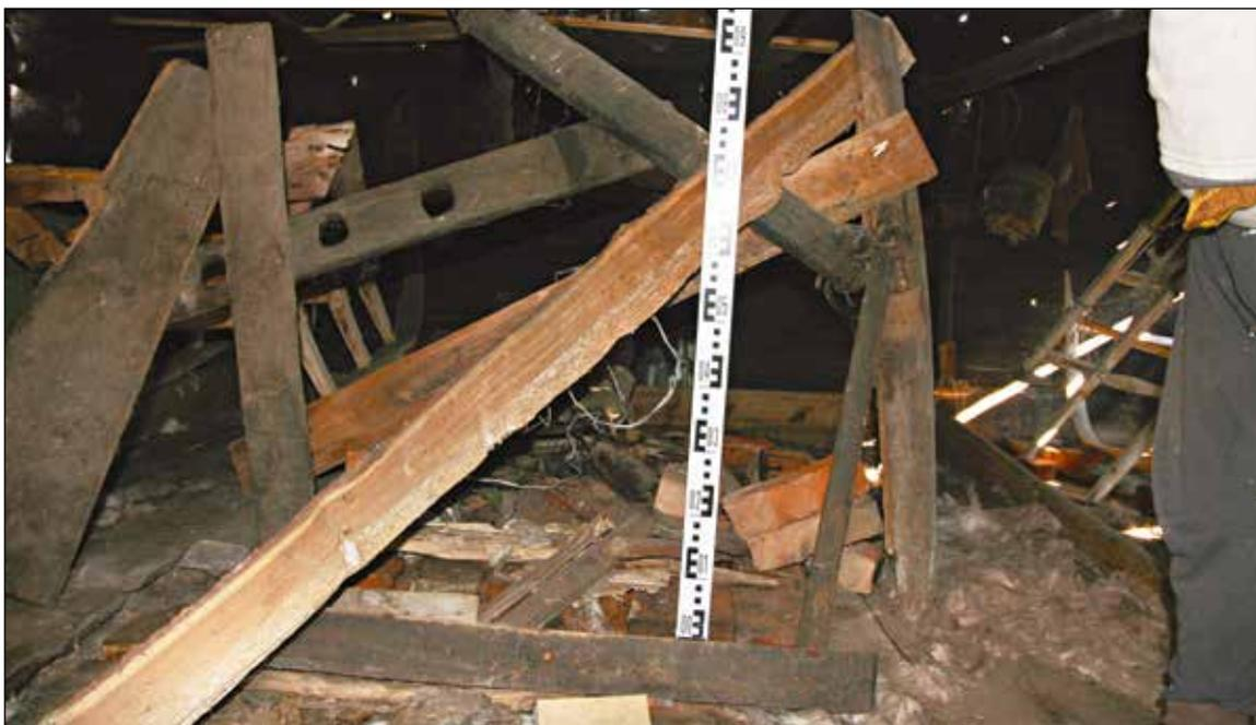
**Рис. 62.** ЯНАО. Шурышкарский район, д. Хашгорт. Постройка 1. Летний «священный» дом А. М. Тырлина. Интерьер. Разрушенный очаг. Видна очажная рама с кирпичной обкладкой. Сохранились стойки очага, поддерживающие вешала. В центре лестница для открывания-закрывания дымового окна. Вид на северо-восточную стену
