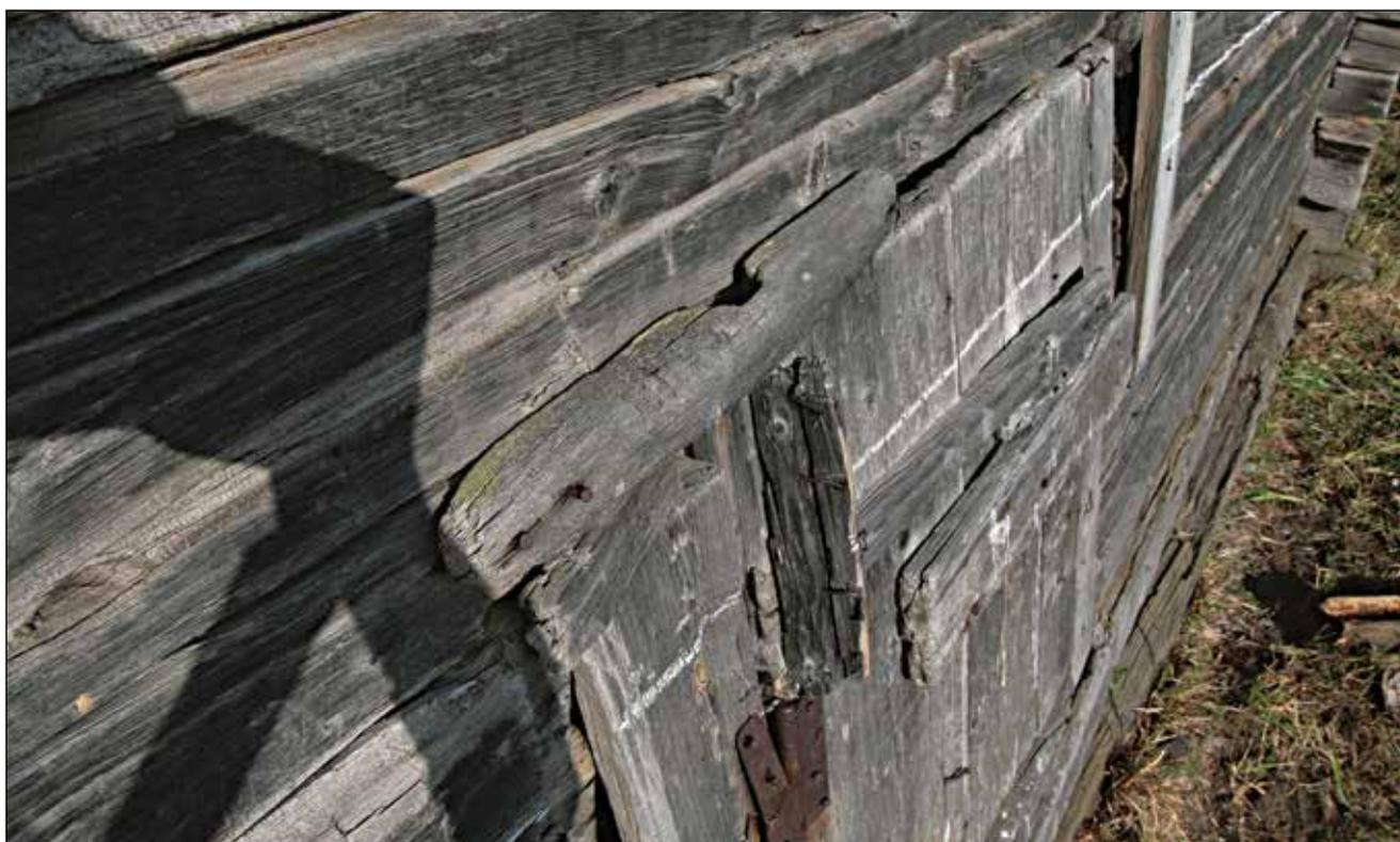
**Рис. 103.** ЯНАО. Шурышкарский район, д. Хашгорт. Постройка 3. Летний дом В. Д. Вакуленко. Фрагмент юго-западного фасада. Дверная конструкция. Деталь первоначальной беспетельной конструкции открывания дверей – гнездо для вставки деревянной втулки. Вид с запада
