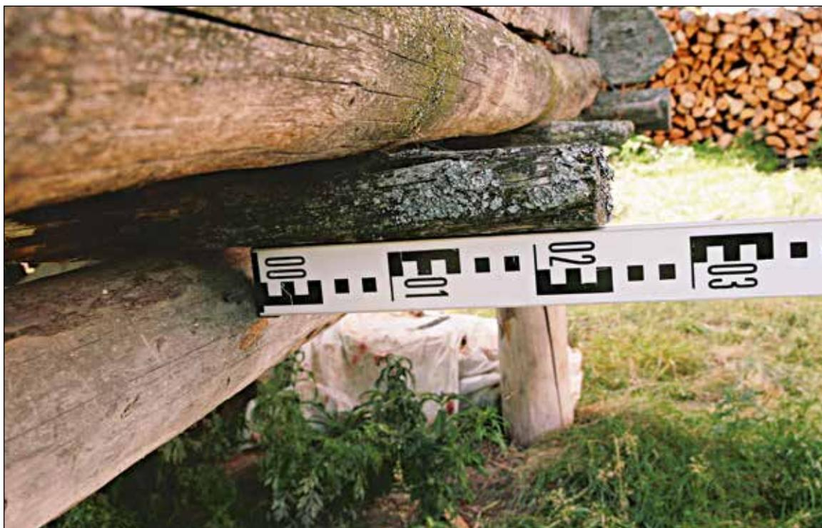
**Рис. 134.** ЯНАО. Шурышкарский район, д. Хашгорт. Постройка 5. Лабаз. Фрагмент северного фасада. Одна из жердей, перекрывающих несущие балки, и на которые устанавливается сруб. Вид с востока
