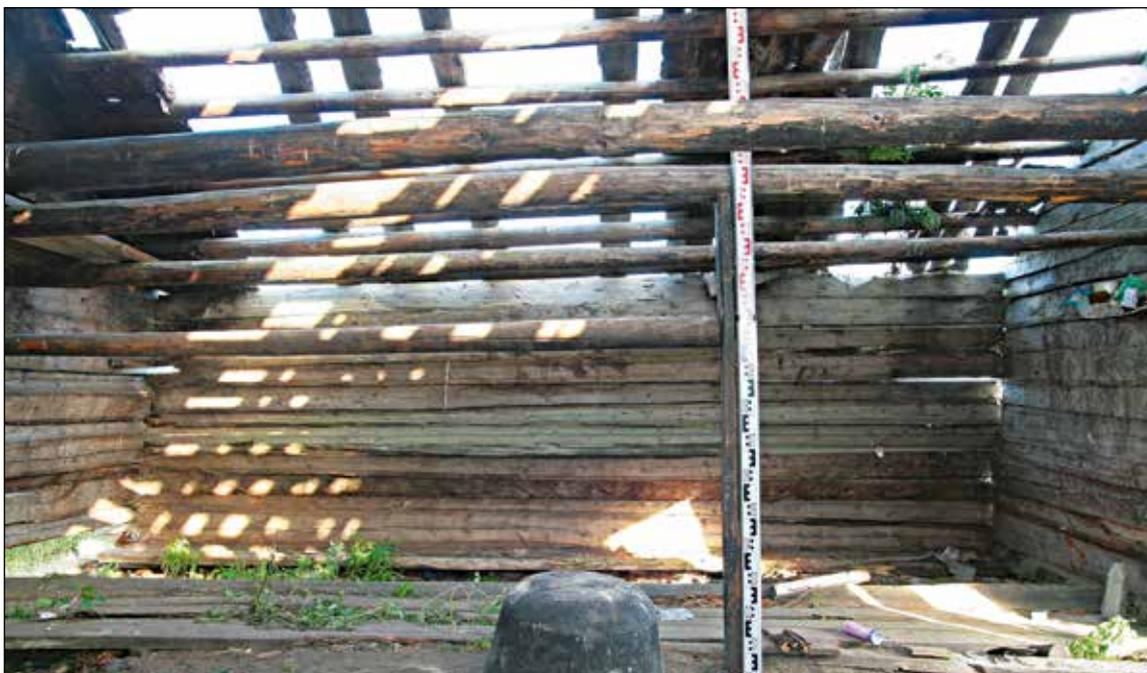
**Рис. 116.** ЯНАО. Шурышкарский район, д. Хашгорт. Постройка 3. Летний дом В. Д. Вакуленко. Интерьер. Остатки дощатого пола. Слева и справа видны две балки, несущие доски пола. Вешала. Стойка, подпирающая среднее вешало. Вид на юго-восточную стену
