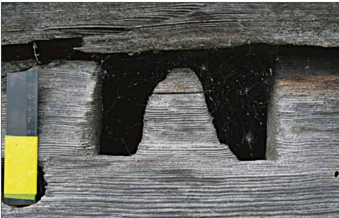
**Рис. 57.** ЯНАО. Шурышкарский район, д. Хашгорт. Постройка 1. Летний «священный» дом А. М. Тырлина. Фрагмент юго-восточного фасада. Пазы от утраченных вкладышей для крепления стоек к стеновому ограждению. Вид с юго-востока
