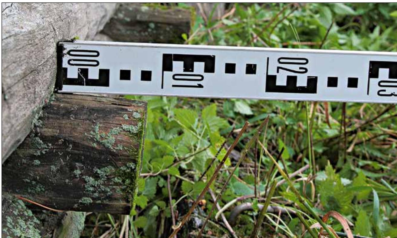
**Рис. 163.** ЯНАО. Шурышкарский район, д. Хашгорт. Постройка 8. Перемещенный летний дом. Фрагмент восточного фасада. Узел врубки в первый венец дома балки, несущей доски пола. Вид с юга
