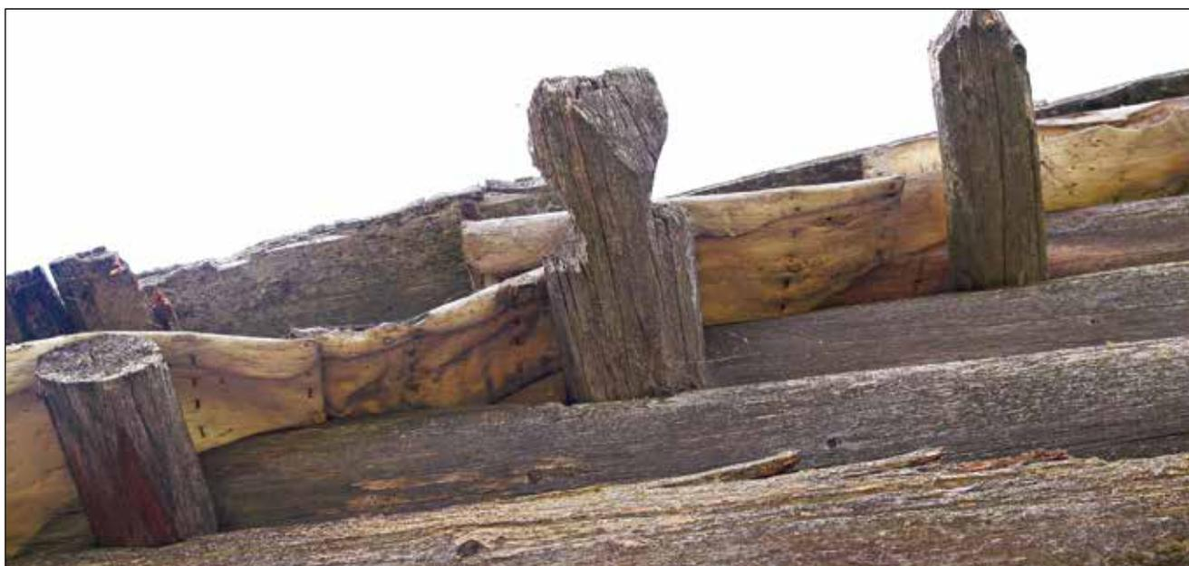
**Рис. 83.** ЯНАО. Шурышкарский район, д. Хашгорт. Постройка 2. Летний дом А. Г. Тырлина. Фрагмент северо-восточного фасада. Узлы врубки слег в плахи фронтона. Край берестяного гидроизоляционного покрытия. Вид с северо-востока
