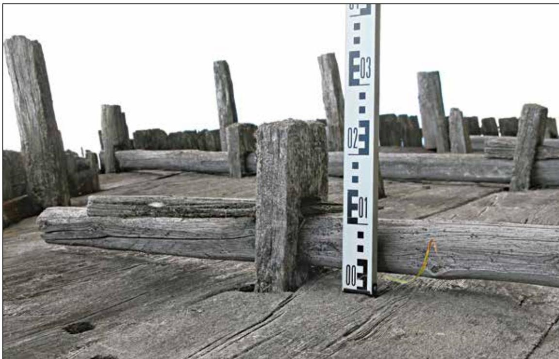
**Рис. 55.** ЯНАО. Шурышкарский район, д. Хашгорт. Постройка 1. Летний «священный» дом А. М. Тырлина. Фрагмент северо-восточного фасада. Узел крепления стойки каркаса деревянным вкладышем с вбитым в него клином к стеновому ограждению. Вид с востока
