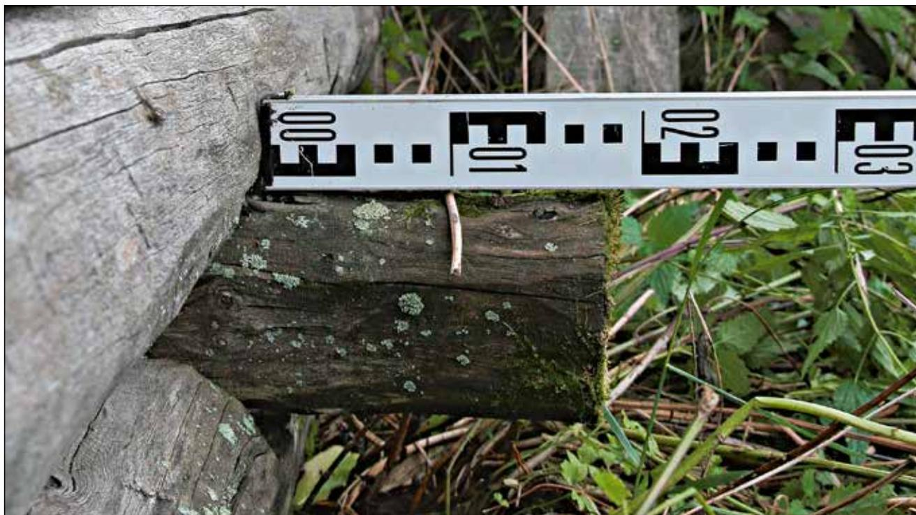
**Рис. 164.** ЯНАО. Шурышкарский район, д. Хашгорт. Постройка 8. Перемещенный летний дом. Фрагмент восточного фасада. Узел врубки в первый венец дома балки, несущей доски пола. Вид с юга
