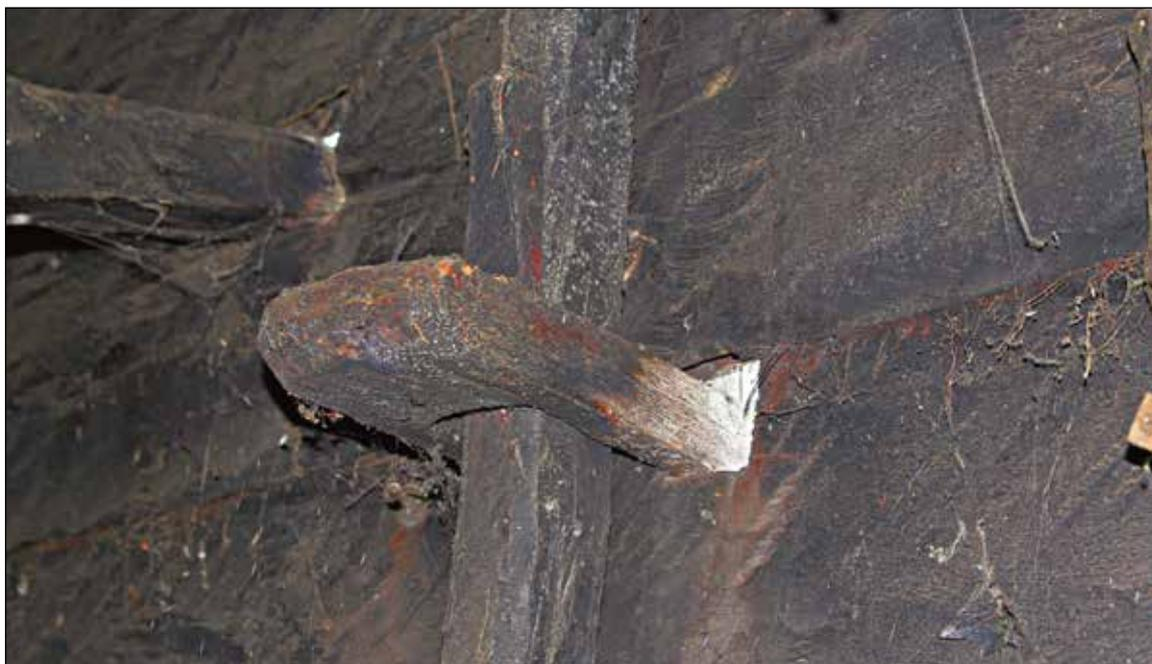
**Рис. 64.** ЯНАО. Шурышкарский район, д. Хашгорт. Постройка 1. Летний «священный» дом А. М. Тырлина. Интерьер. Узел крепления стойки каркаса к дощатому стеновому ограждению деревянным вкладышем. Вид на юго-западную стену
