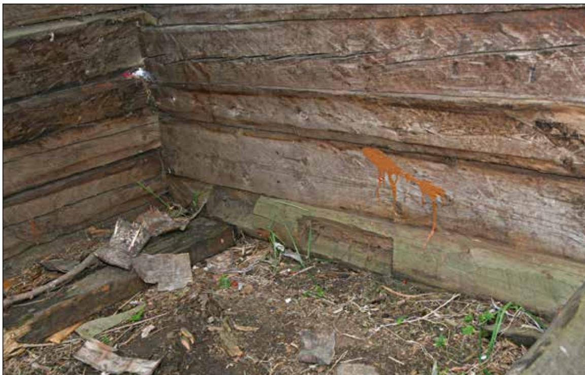
**Рис. 118.** ЯНАО. Шурышкарский район, д. Хашгорт. Постройка 3. Летний дом В. Д. Вакуленко. Интерьер. Остатки дощатого пола. В окладном венце врубки под доски пола. Вид на южный угол
