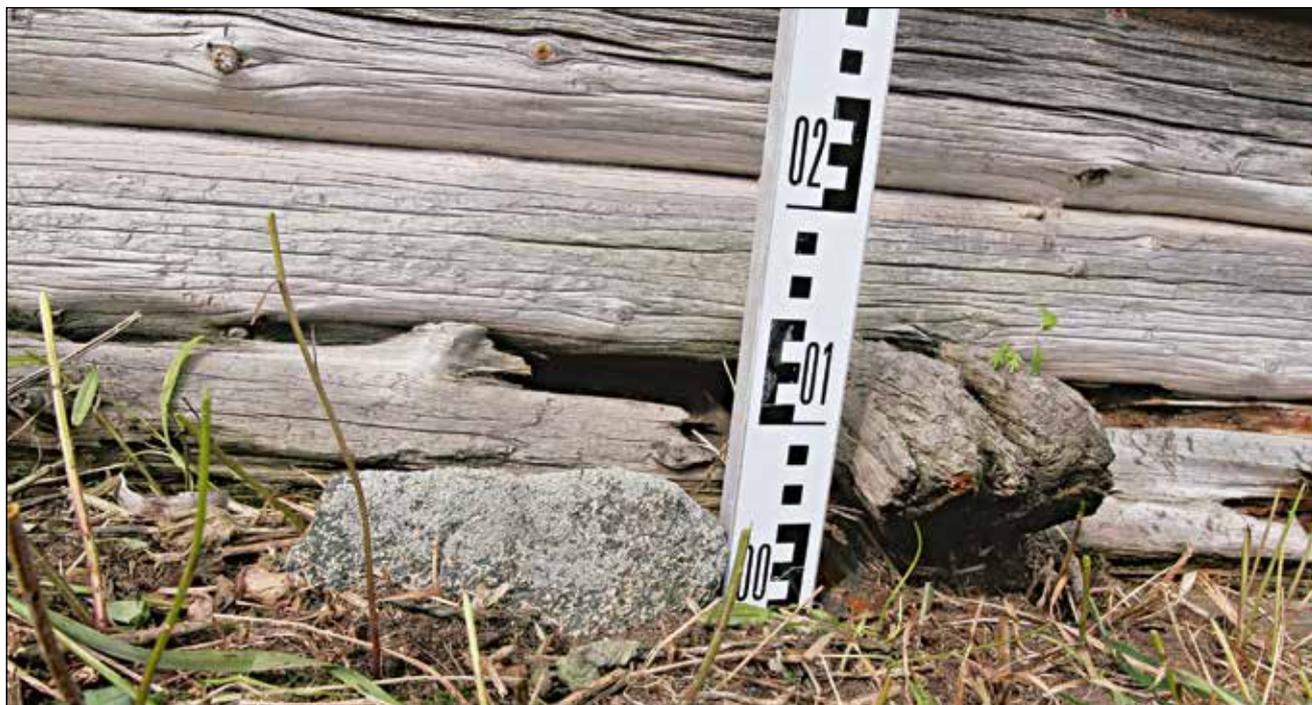
**Рис. 80.** ЯНАО. Шурышкарский район, д. Хашгорт. Постройка 2. Летний дом А. Г. Тырлина. Фрагмент юго-восточного фасада. Узел врубки балки перекрытия, несущей пол, в продольную стену дома. Вид с юго-востока
