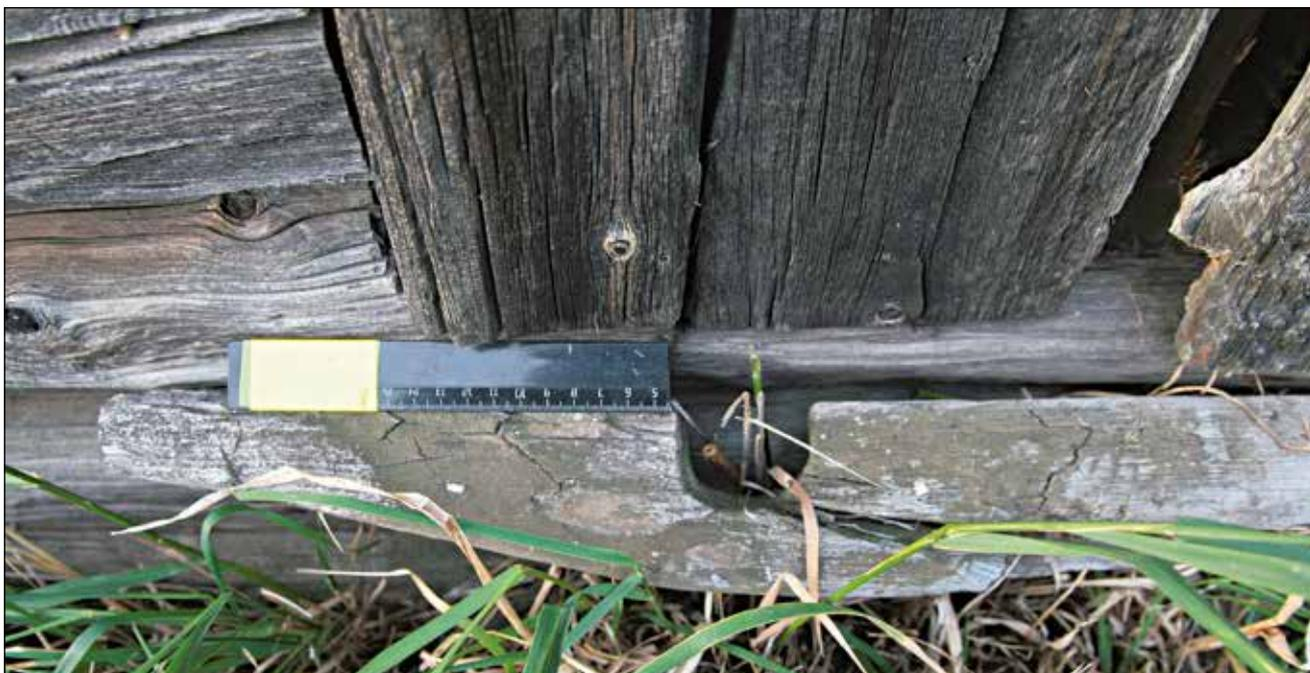
**Рис. 172.** ЯНАО. Шурышкарский район, д. Хашгорт. Постройка 9. Старый амбар. Фрагмент южного фасада. Фрагмент дверной конструкции. Гнездо, вероятно, для дверной деревянной втулки беспетельного открывания дверей. Вид с юга
