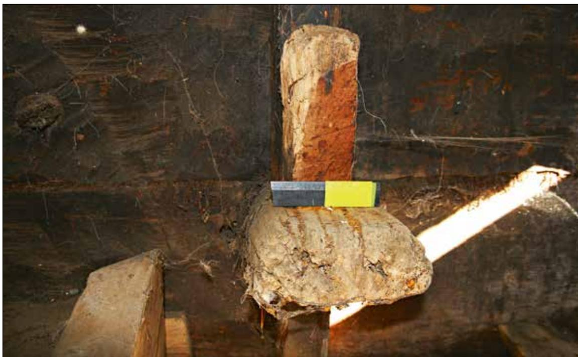
**Рис. 63.** ЯНАО. Шурышкарский район, д. Хашгорт. Постройка 1. Летний «священный» дом А. М. Тырлина. Интерьер. Узел крепления стойки каркаса к дощатому стеновому ограждению деревянным вкладышем. Слева приподнятый над полом настил за очагом. Вид на северо-восточную стену
