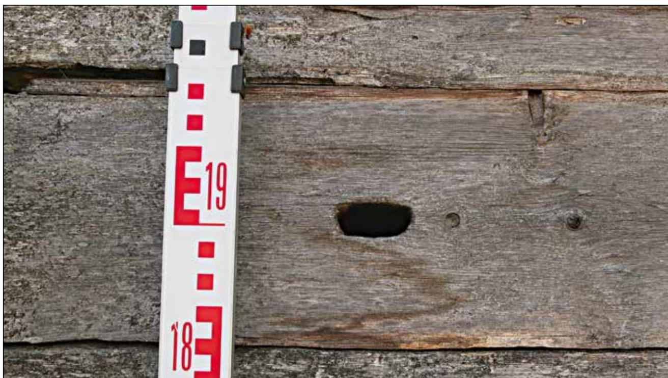
**Рис. 141.** ЯНАО. Шурышкарский район, д. Хашгорт. Постройка 5. Лабаз. Фрагмент северного фасада. Овальное отверстие в пятом венце. Вид с севера
