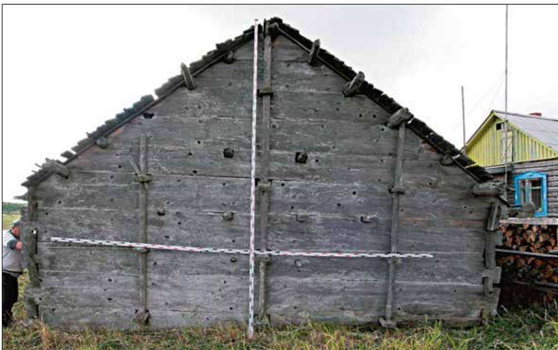
**Рис. 42.** ЯНАО. Шурышкарский район, д. Хашгорт. Постройка 1. Летний «священный» дом А. М. Тырлина. Фрагмент северо-восточного фасада. Узлы крепления стоек каркаса деревянными вкладышами к стеновому ограждению. Узлы врубки вешал
